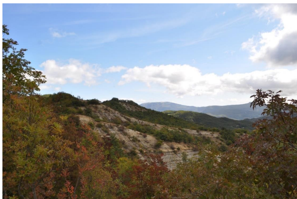
Calanchi e affioramenti rocciosi a circa 900 m s.l.m. caratterizzano le pendici sopra la località di Fraghetto, nel comune di Casteldelci.
